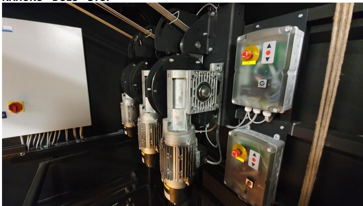
Obr. 4 TAHOVÁJEDNOTKY PROSPEKTOVÉHO TAHU MOTOR S OVLADAČEM NAHORU - DOLU - STOP
